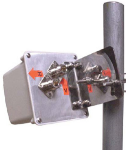
Figure 25. Installing Mini Panel Antenna to the Pole
