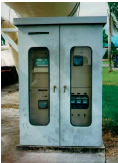
4 equipos Minilog B registran la entrada de aguas residuales en una planta de tratamiento en el sudeste asiático.
