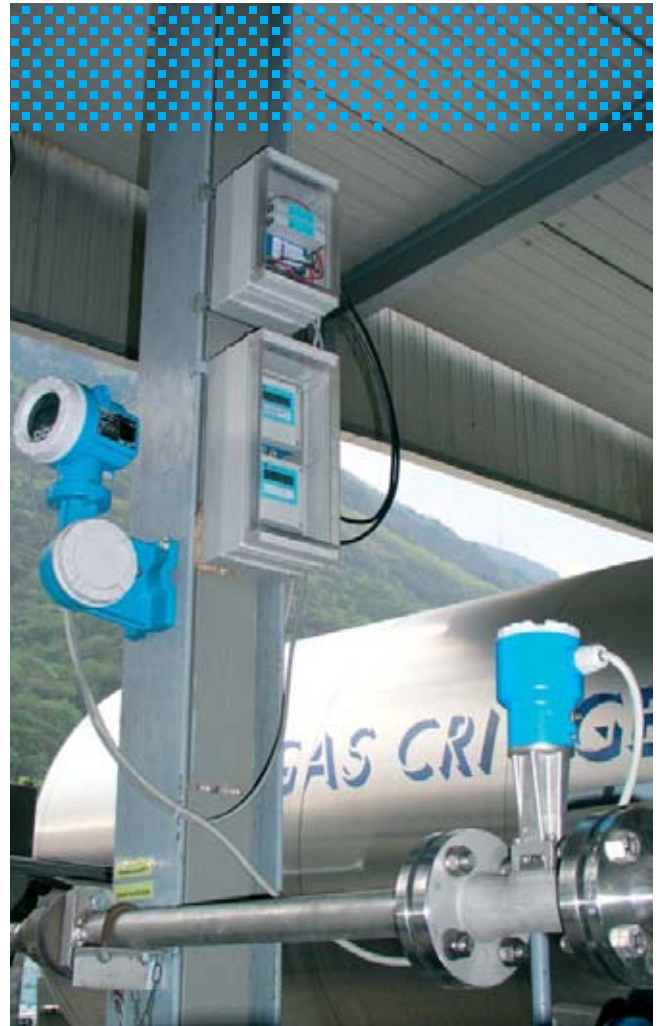
2 equipos Minilog B utilizados para medición de nivel y dosificación.
