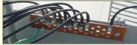
Antenna Buss Bar
