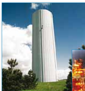
Traitement de l'eau
