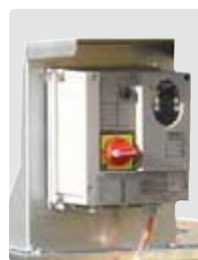
La sonda di pressione invia l'informazione al variatore di frequenza che modifica la velocità del ventilatore
