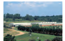
Mitutoyo Sul Americana Ltda. Factory (Suzano)
