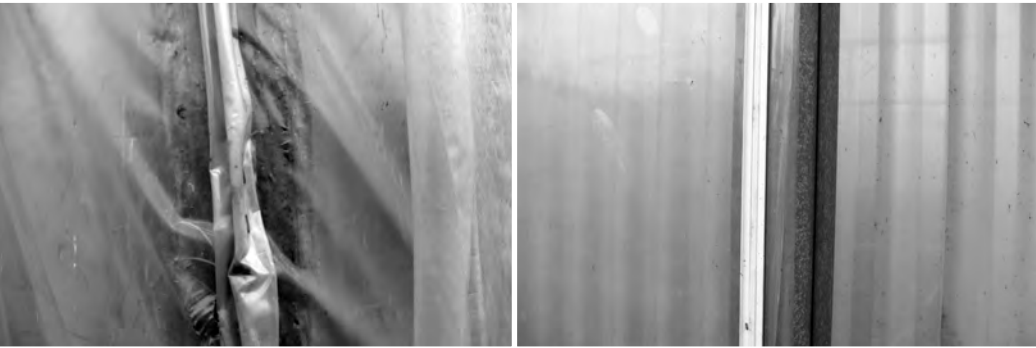
Figura 23. Sistema de fijación de plástico tradicional (izquierda) y a presión (derecha).
