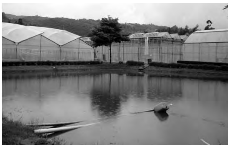
Figura 38. Reservorio de agua para riego.
