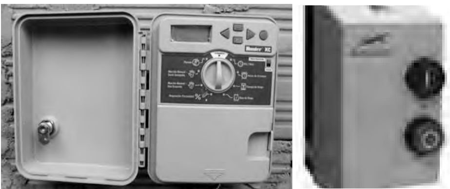
Figura 45. Controlador de riego (izquierda), arrancador electrobomba (derecha).
