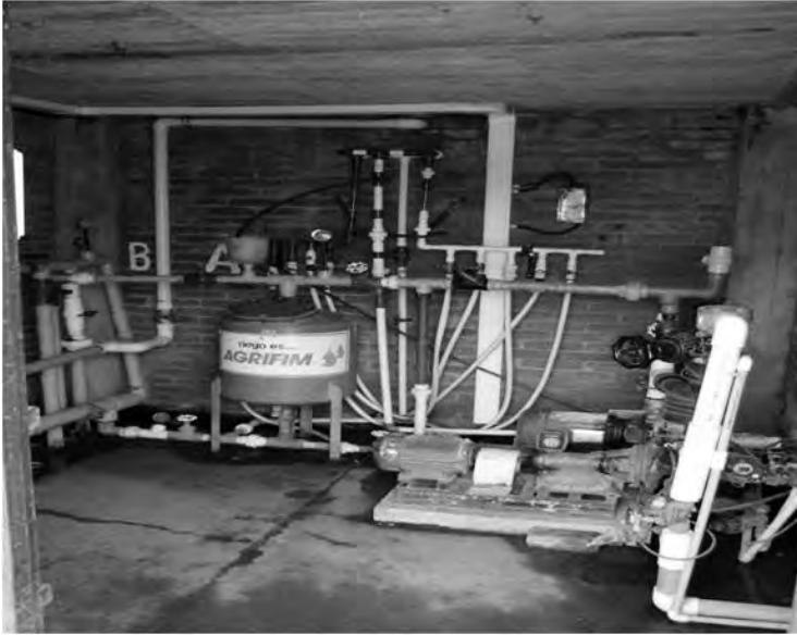
Figura 39. Cabezal principal de riego.
