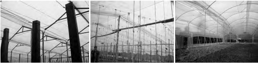
Figura 22. Invernadero de madera (izquierda), guadua (centro) y de metal (derecha).
