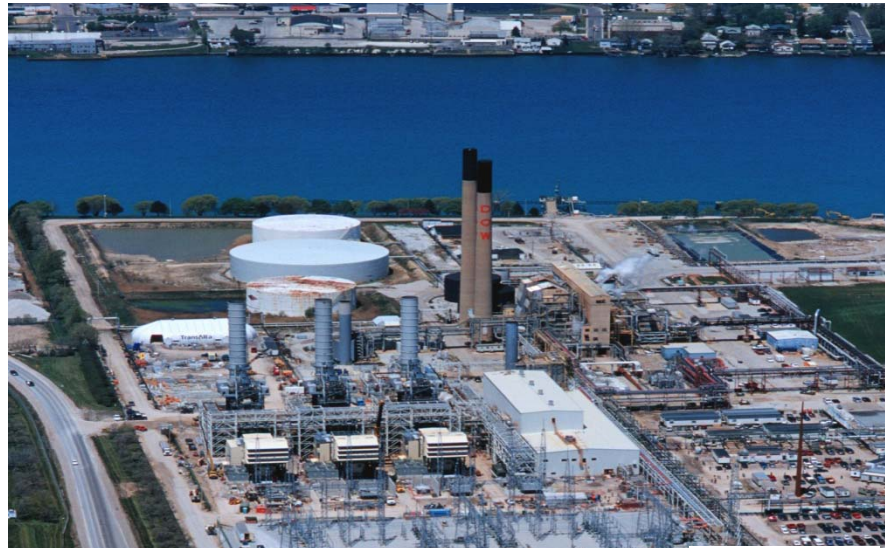
TransAlta Sarnia 650 MWe (JP Zanyk)
