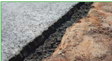
Edge slumping /poor consolidation at edge
