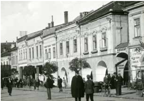
▲ 8. Mariánske námestie, pohľad na vstup do Burianovej ulice.
