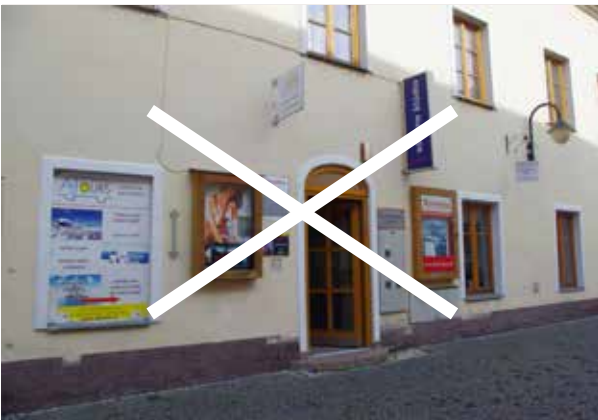
▲ 57. Vitríny na fasáde narúšajú rytmus okenných otvorov, svojím obsahom nemajú na danej budove opodstatnenie.
