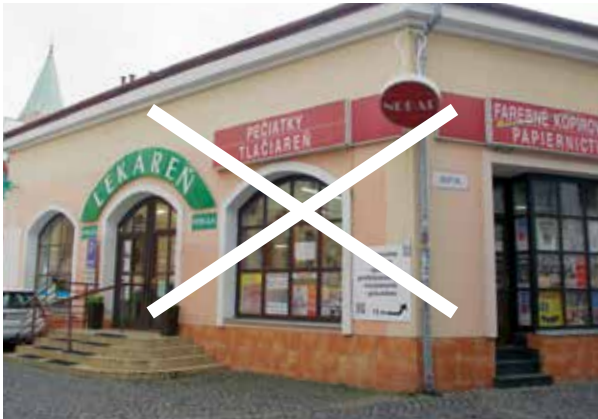
▲ 45. Nevhodná forma vývesných štítov vytvára rušivý prvok budovy.
