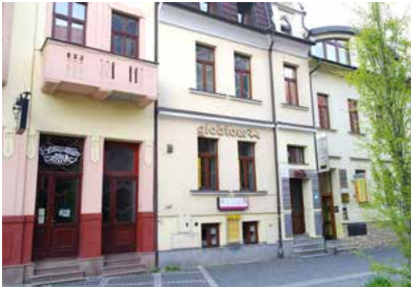
▲ 76. Ulica Dolný Val č. 5 - starý stav, kedy na fasáde bolo príliš veľa reklamných prvkov.
