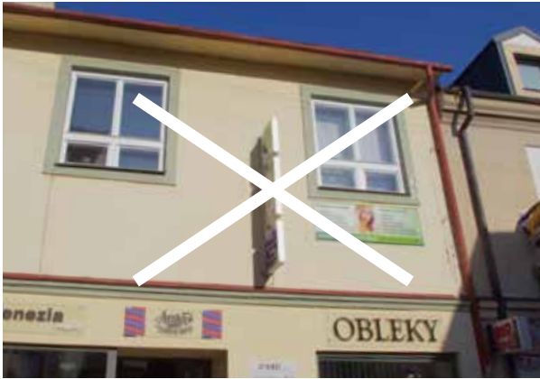
▲ 51. Necitlivé osadenie výstrče do stredu fasády nerešpektuje architektúru budovy.
