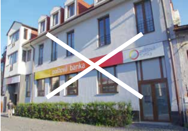
▲ 40. Reklama nerešpektuje členenie fasády, prekryva časť okenných otvorov.
