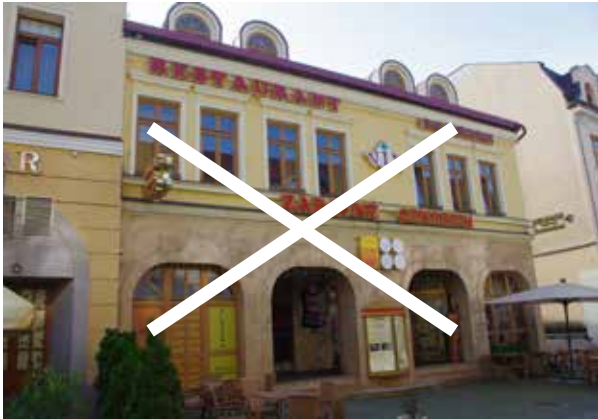
▲ 46. Umiestnenie vývesného štítu nad kordónovú rímsu narušuje architektúru budovy (viď. Schéma 2).
