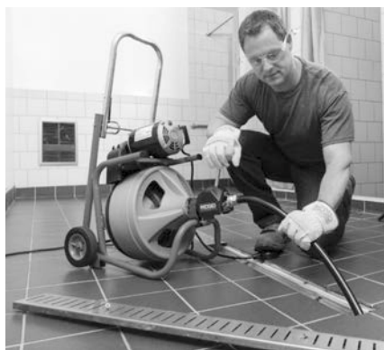
Figure 16 – Utilisation du guide-câble
