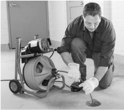
Figura 13 – El operario en posición correcta para trabajar, alimentando el cable manualmente
