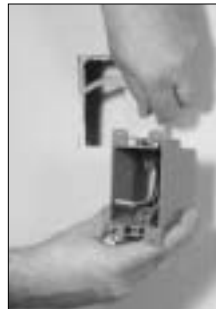
Insert Wires
