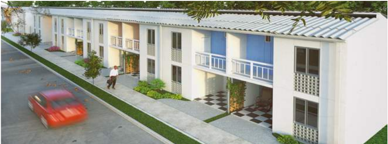
Fachada de conjunto con ampliación del balcón que cubre y amplía la terraza en el acceso
