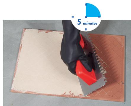
**3.3.** Aplique **Concolor® 2 en 1** en la parte posterior del mosaico y coloque sobre el soporte. Deje reposar por 5 minutos para iniciar el proceso de emboquillado.
