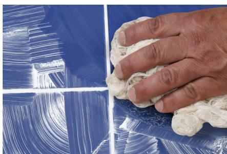
**3.5.** Para la limpieza inicial, después de instalación, permita que el material adquiera suficiente dureza, usualmente son 30 minutos dependiendo de la humedad y la temperatura relativa del sitio. Remueva el exceso de producto del revestimiento con una esponja húmeda. Enjuague periódicamente la esponja con agua limpia.
