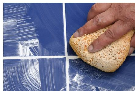
**3.6.** Después de aproximadamente 2 horas, con un paño limpio y seco limpie la superficie del revestimiento en forma diagonal al sentido de la junta. Tenga cuidado con el polvo que puede estar sobre el revestimiento pues podría impregnar la junta ocasionando contaminaciones y cambios de tono. ⓘ
