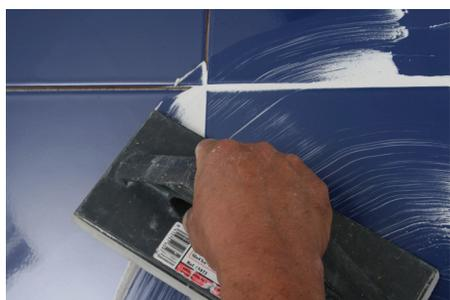
**3.4.** Aplique la mezcla de **Concolor® 2 en 1** con una llana de goma, tipo termoflex Rubí, en forma diagonal a la dirección de las juntas, presionando para que la mezcla entre, cuidando que el producto quede compacto y libre de vacíos, hendiduras o fisuras.
