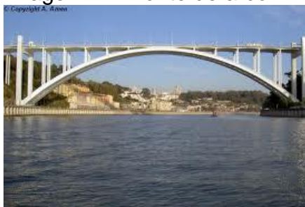
Imagem 1 – Ponte de arco
