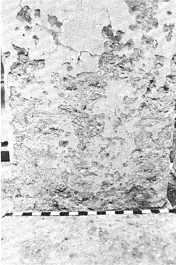
Fig. A.2.9.3.a—Scaling (medium)
