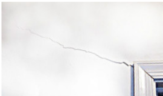
Drywall Crack
