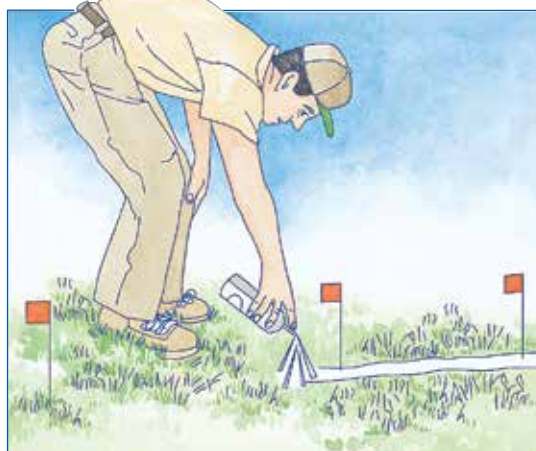
Antes de hacer la zanja, utilice pequeñas banderas y pintura en aerosol para hacer un esquema del sistema de riego.
