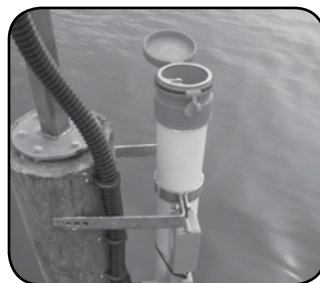
Montaje en muelle
