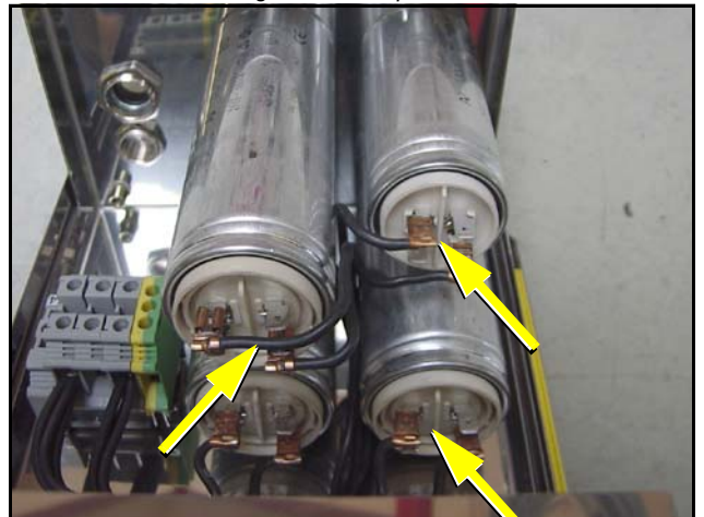
Fig. 8.5.1-1: Capacitor
