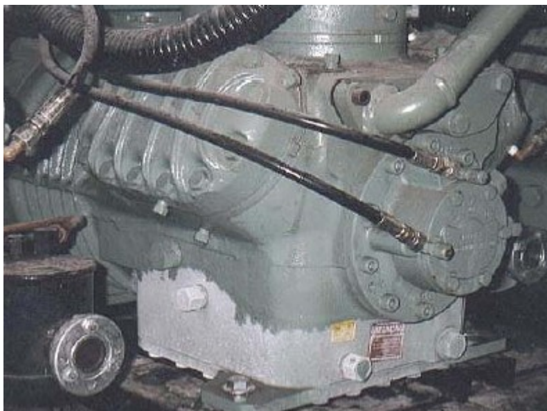
Figura 18: Compressor com cárter congelado (Silva, 2004).
