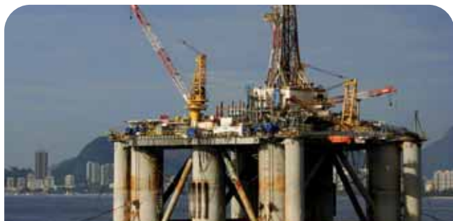
De intrinsieke veilige oplossingen van Zenitel waarborgen dat radiocommunicatie beschikbaar is op elk punt van het platformcomplex.
