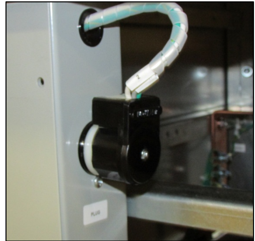
Fig. 34 Test Power Receptacle
