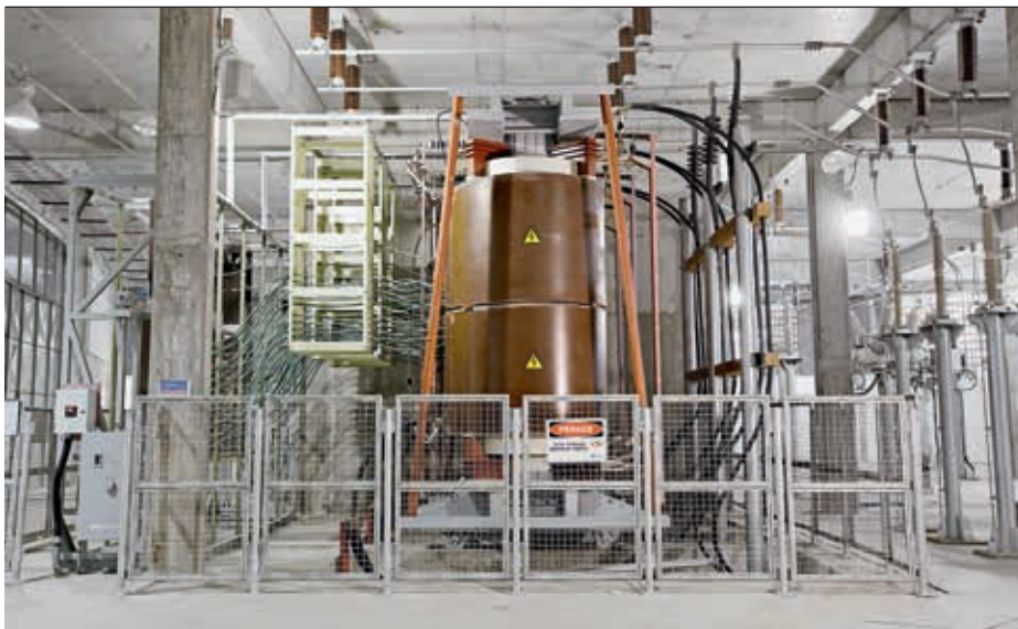
5a Avec changeur de prises en charge sec (à gauche)
