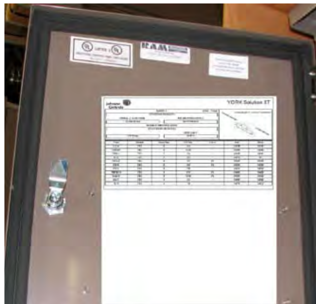
FIG. 3-1 – TERMINATION CHART INSIDE ENCLOSURE DOOR
