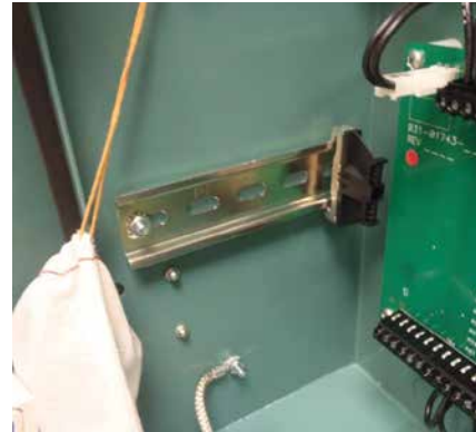
Figure 52 - DIN rail end block
