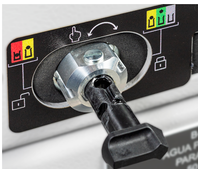
L'opérateur de verrouillage relâché et en position verrouillé
