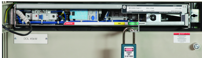
Levier de retrait en position déconnectée (et verrouillée)
