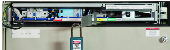
Levier de retrait en position de test (et verrouillée)
