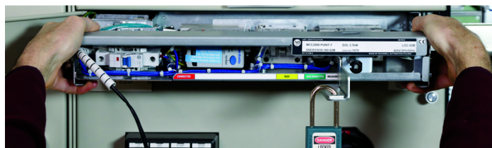
Levier de retrait en position dégagée (et verrouillée)
