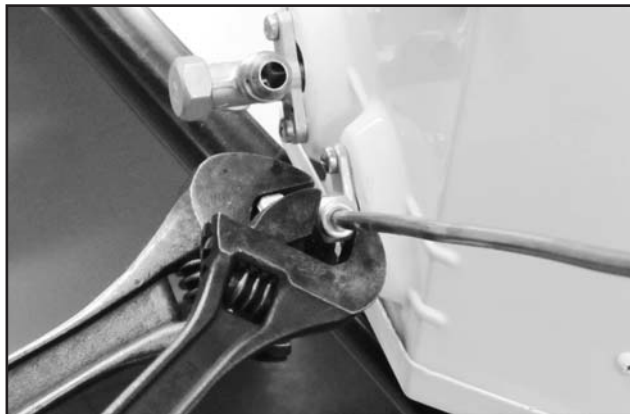
FIG. 31 - FIXAÇÃO DA PORCA
