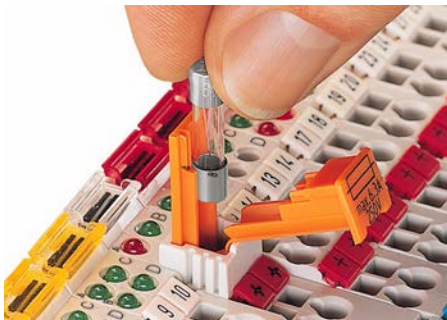
Abbildung 10: Sicherung wechseln
