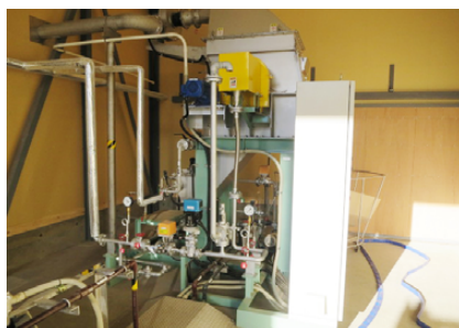
CD dryer (Kitami Mokuzai Co., Ltd.)
