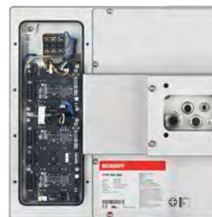
Open wiring space
