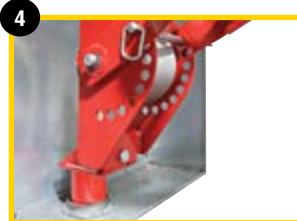
4 Place in conduit
