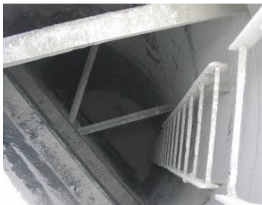
Silo con tirantes
