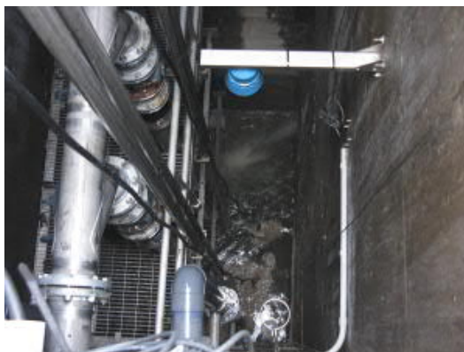
Pozos de bombeo
