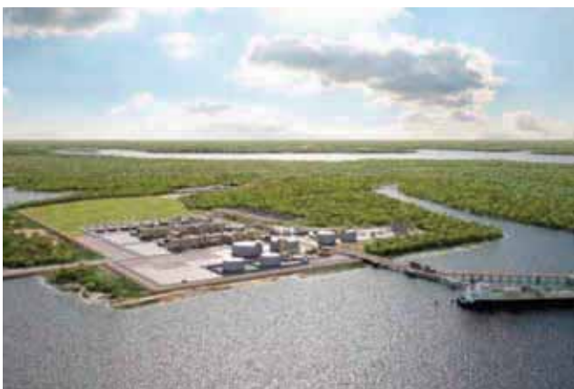
Ichthys Onshore LNG Facility - Australia
