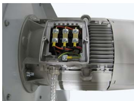
Figure 3.15 Fan motor wiring
