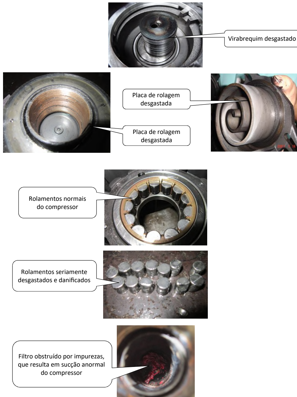
Figura 92: Efeitos do óleo deteriorado do compressor
