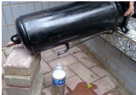
Figura 89: Drenagem do óleo de um compressor
