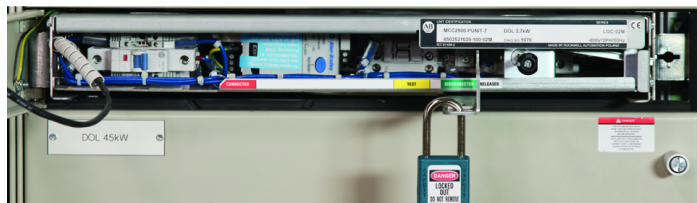
Dźwignia w pozycji Odłączone (i zablokowanie)
