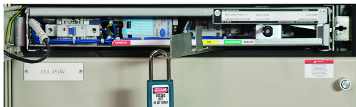
Dźwignia w pozycji Próba (i zablokowanie)
