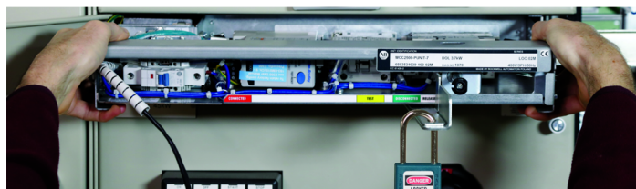
Dźwignia w pozycji Wyciągnięte (i zablokowanie)
