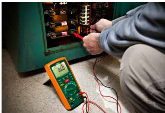
Vérification de la tension sur un tour
