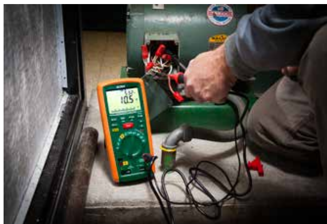
Test d'isolement sur un moteur de pompe
