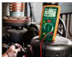
Test d'isolement sur un moteur de pompe
