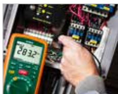
Vérification de la tension sur un démarreur de moteur
