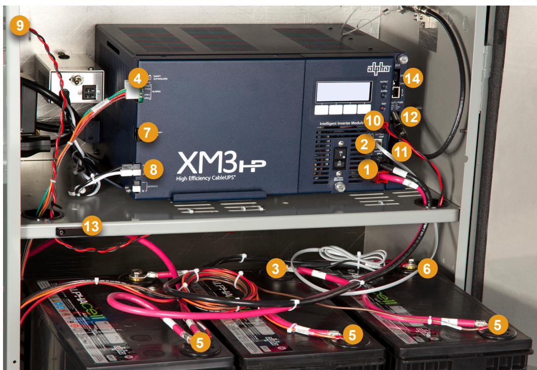
Fig. 4-1, Componentes del sistema XM3-HP
