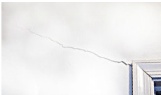
Drywall Crack
