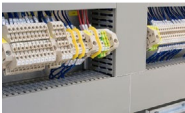
Afbeelding 10-1 Groeperen en scheiden van klemmen voor het aansluiten van externe leidingen
