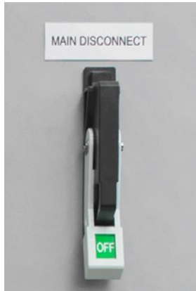
Afbeelding 13-20 Bedieningshendel van hoofdnetscheider
