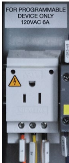
Afbeelding 6-18 Vermelding bij een contactdoos
