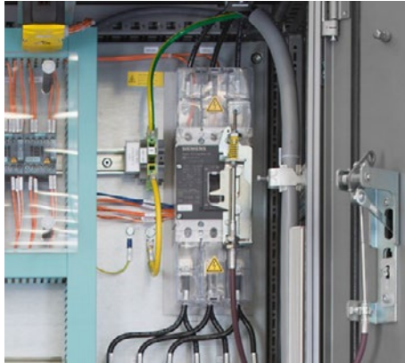
Afbeelding 5-8 Aansluiting van de voedingsleiding op de netscheider
