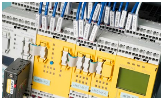
Afbeelding 11-6 Voorbeeld van een aanduiding voor een leiding
