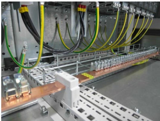
Afbeelding 8-1 Aardingsconcept van een industriële besturingskast
