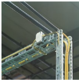
Afbeelding 11-19 Voorbeeld van onbedekte kabels
