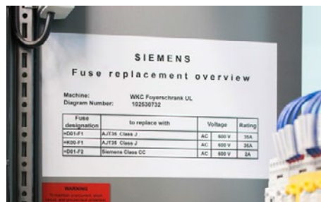
Afbeelding 13-19 Voorbeeld van aanduiding voor zekeringhouders:
