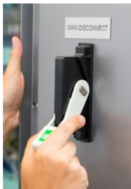
Afbeelding 5-17 Voorbeeld: Uitschakelen zonder gereedschap door een hendel aan de achterzijde van de deur te bedienen.
