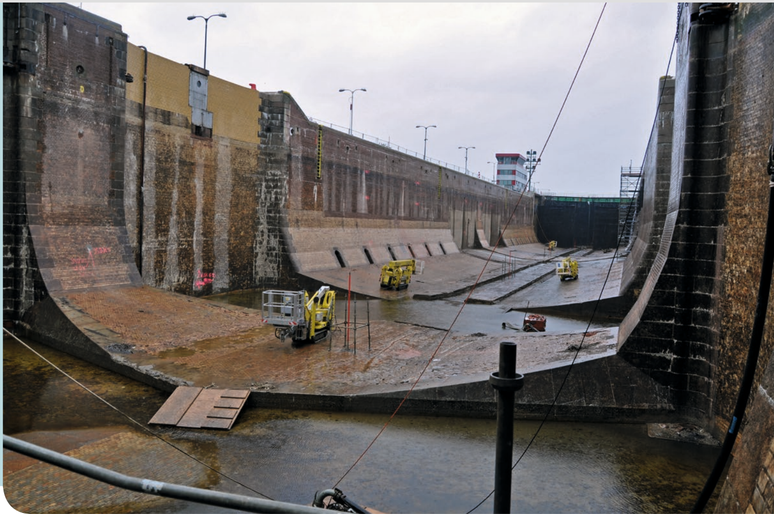
■ Listos para la renovación segura: la esclusa vacía del barco se inspecciona mientras se controla la estructura.
