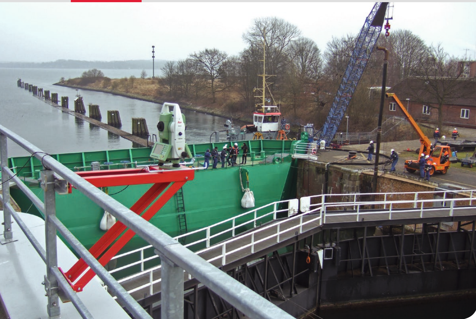
■ Una estación total de Leica Geosystems realiza mediciones para observar los posibles movimientos de la pared de la cámara.
