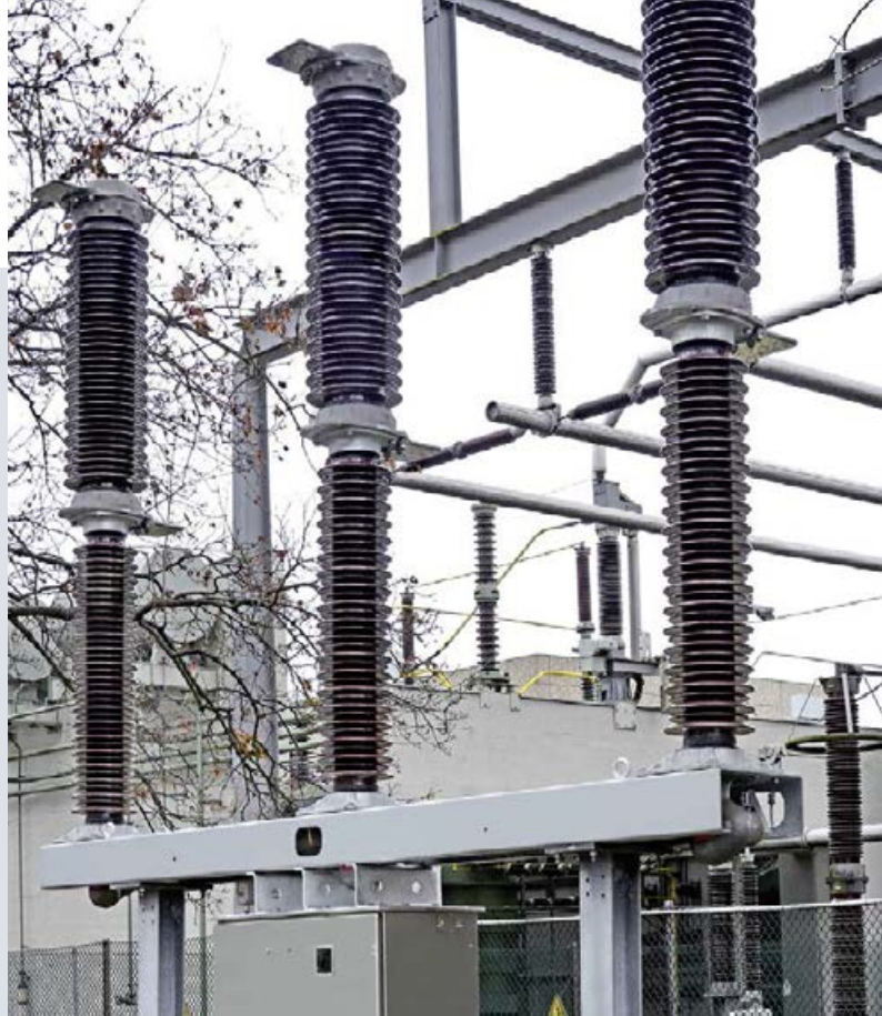
Fig. 9: 3AP1 FG 145 kV
