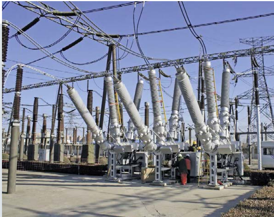
Fig. 18: 3AP1 DTC 245 kV
