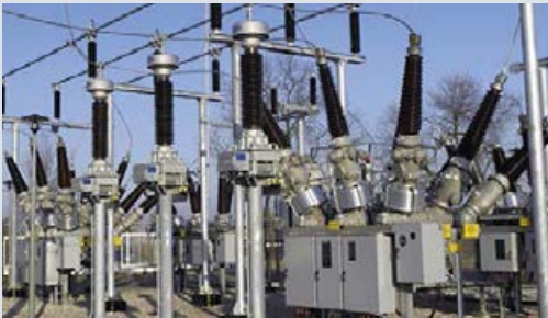
Fig. 17: 3AP1 DTC 145 kV
