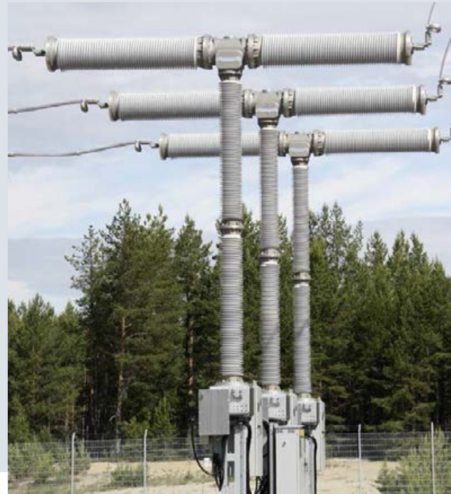
Fig. 23: 3AP2 DCB 420 kV
