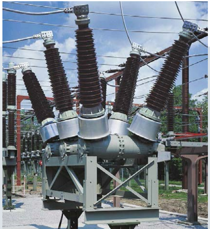
Fig. 12: SPS2/3AP1 DT 145 kV
