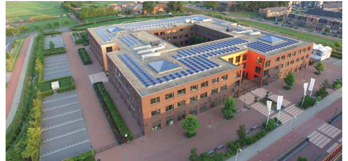
The Netherlands, 303kW De Meerwaarde, Barneveld
