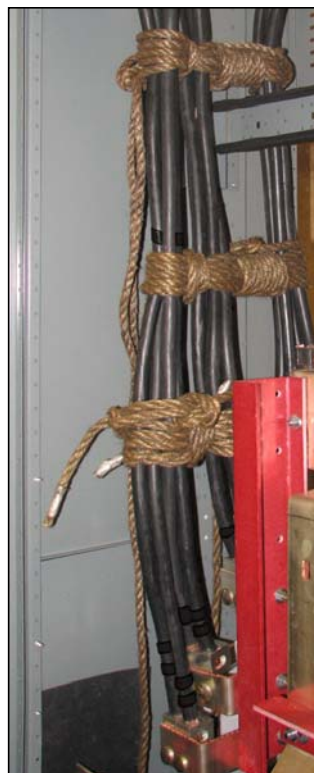
Figura 25 – Ejemplo de sujetador de cables
