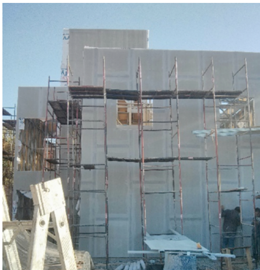
Foto 2 – Estrutura revestida com OSB e placa cimentícia.
