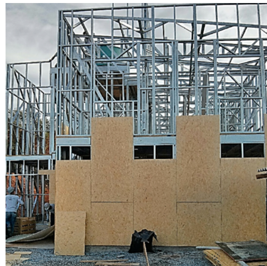
Foto 1 – Estrutura e revestimento externo.
