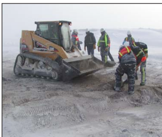
Prudhoe Bay Spill, ADEC
