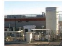
Glendale Landfill Biogas 3 MW
