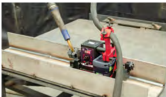
Welding edge to edge
