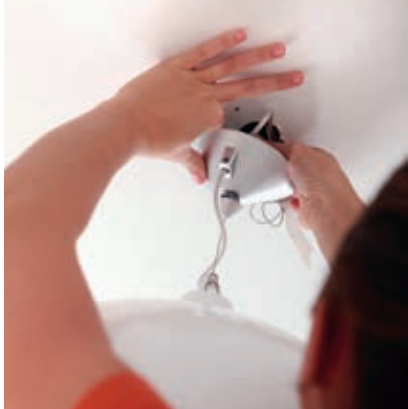
CONNEXION D'UN LUMINAIRE SUR SOCLE DCL (1)
